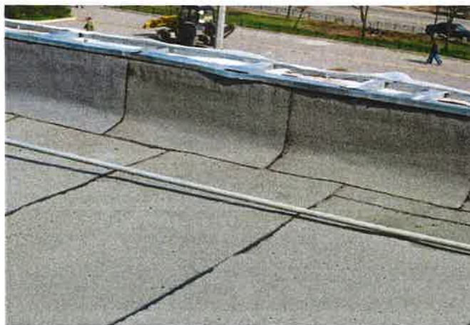
Рисунок 2.1. «Техноэласт ЭКП» или аналогичный по техническим характеристикам – кровельный гидроизоляционный материал для монтажа верхнего слоя кровельного покрытия
