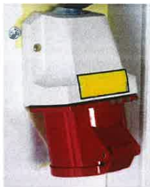
Рисунок 5.5. Образец розетки с крышкой IP54 для подачи электропитания в ГРП от генератора
