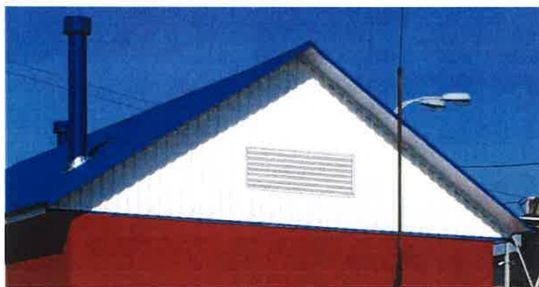
Рисунок 2.4. Крыша двускатная с вентиляционной решеткой (отдушиной)
