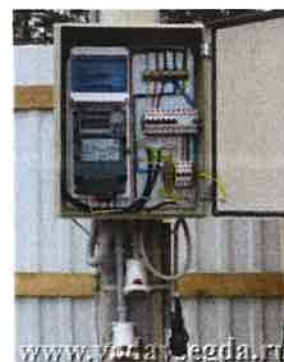
Рисунок 5.6. Образцы силовых электрощитов: взрывозащищенного (фото слева) и наружной установки (фото справа)
