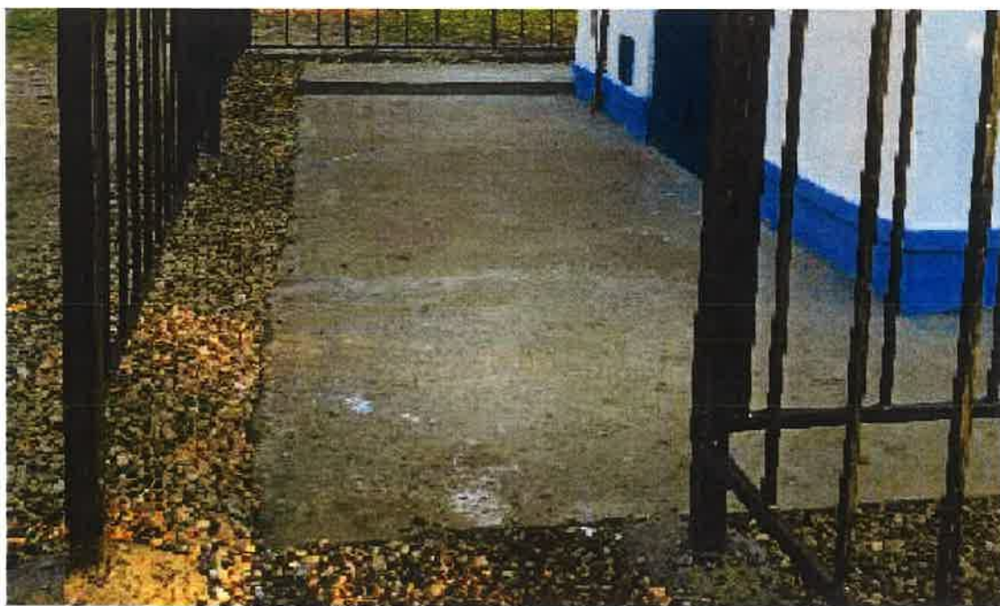
Рисунок 4.1. Отсыпка гравия вокруг отмостки
