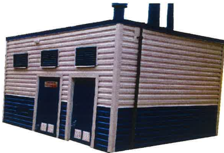
Рисунок 5.11. Токоотвод крышевого устройства молниезащиты
